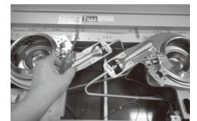
3. 利用調整螺絲來調整瓦斯爐至適當位置並固定。
